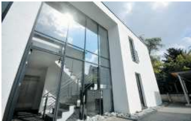
Funktion und Ästhetik vereint: Die Treppenhauseinrichtungen auf der Südostseite bieten ein Höchstmaß an Transparenz.
